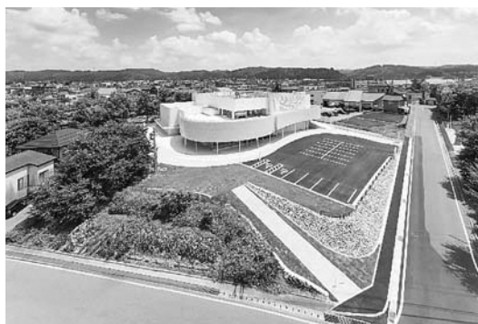
新館の外観（上方から）
