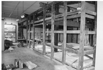
移築民家解体作業（旧館）
