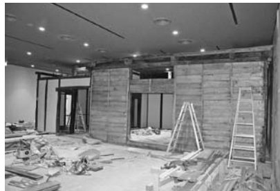
移築民家組み上げ作業（新館）
