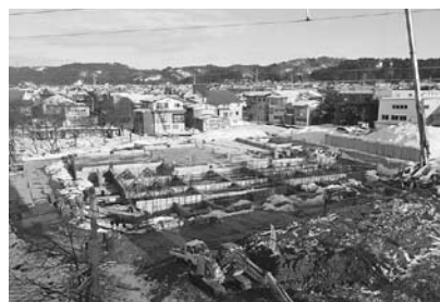
1・2工区床スラブ・3工区基礎
