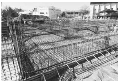
基礎梁・ピットスラブ配筋
