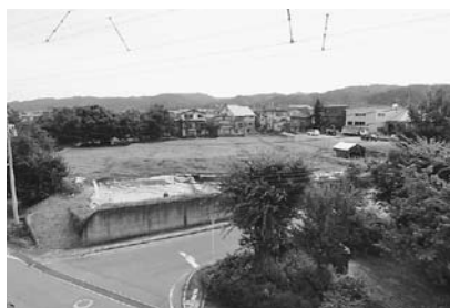
工事着手前の建設予定地
