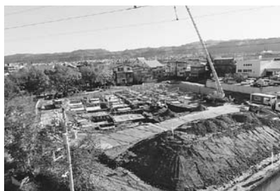
1・2工区の基礎ベース
