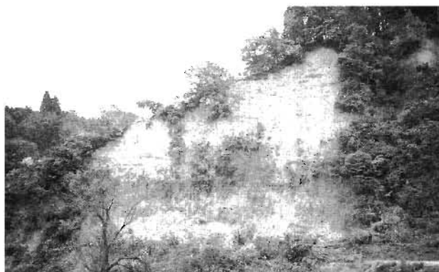
崩落した秋葉山城跡
