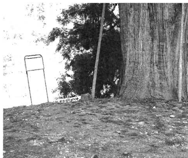
地盤に亀裂に入った小貫の大杉 倒れた標柱と傾いた説明板
