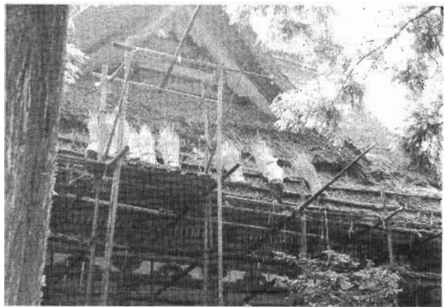
神宮寺観音堂茅屋根修理 一挿し起こし作業一
