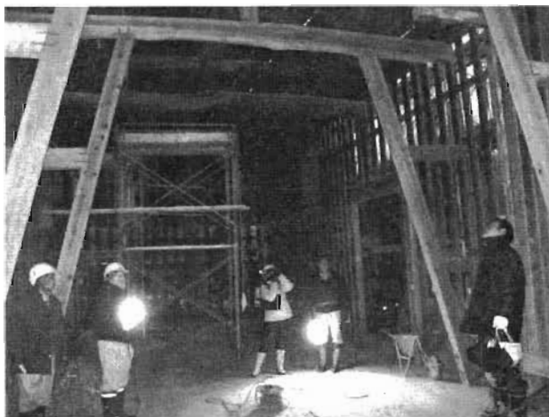
星名家住宅蔵解体工事
