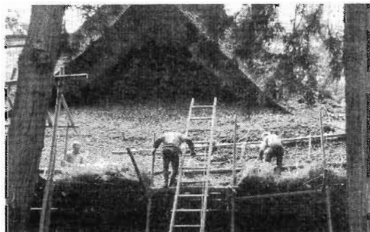
写真7 葺替工事中の観音堂
