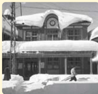
雪中の旧東北電力十日町支店 本町3丁目／昭和29年1月
